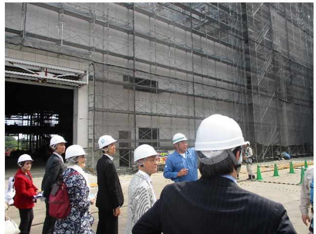
①横須賀市焼却施設建設現場視察
